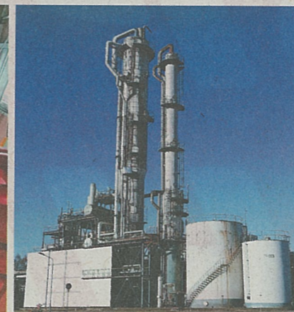
日産化学富山工場のアンモニア製造設備—富山市婦中町笹倉
